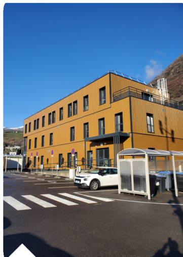
SNCF Réseau Tunnel Euralpin Lyon-Turin (TELT) à Saint-Jean-de-Maurienne
