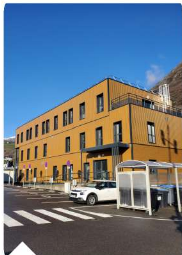
SNCF Réseau Base vie TELT à Saint-Jean-de-Maurienne
